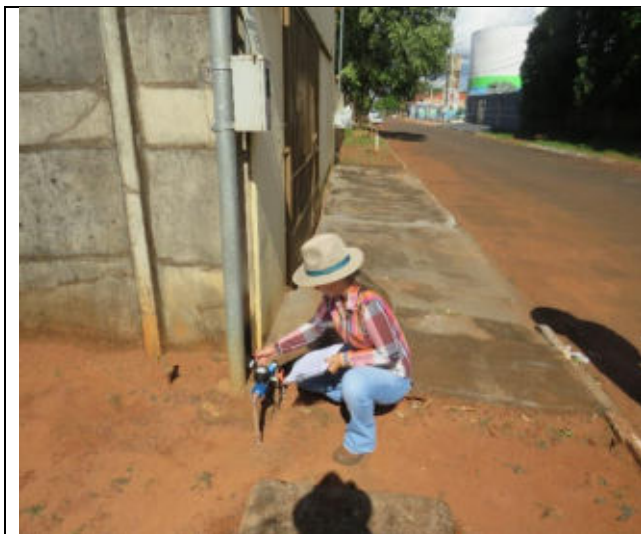
Autor: AMAE Descrição: Equipe da AMAE realizando a conferência de hidrômetros instalados.
