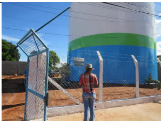
Autor: AMAE Descrição: Vistoria no reservatório Colombo 04, localizado na rua 74, São Simão.
