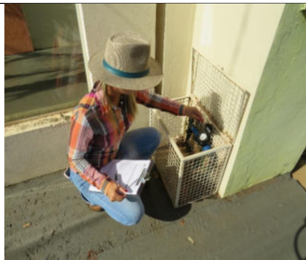
Autor: AMAE Descrição: Equipe da AMAE realizando a conferência de hidrômetros instalados.
