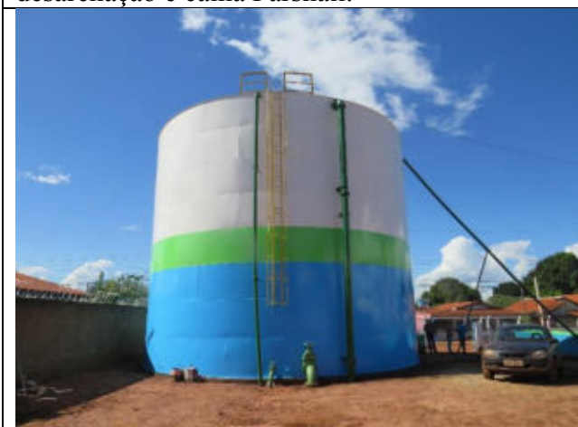
Autor: AMAE Descrição: Acompanhamento das ações de manutenção já realizadas no reservatório localizado na rua 74, São Simão.
