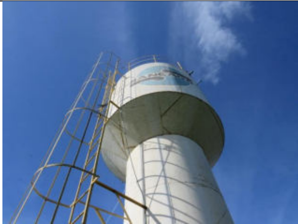
Autor: AMAE Descrição: Guarda corpo no teto e escada marinheiro.
