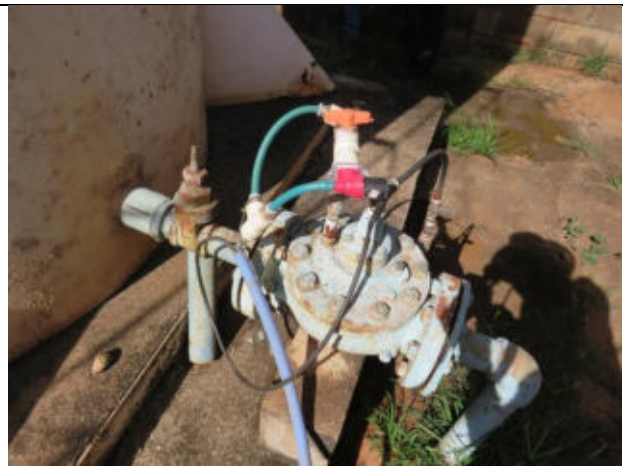
Autor: AMAE Descrição: Sistema de cloração.
