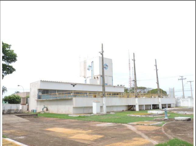
Autor: AMAE/RIO VERDE Descrição: Visão geral da ETA Central
