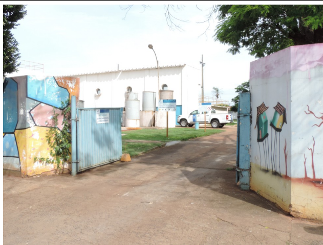
Autor: AMAE/RIO VERDE Descrição: Entrada ETA Central
