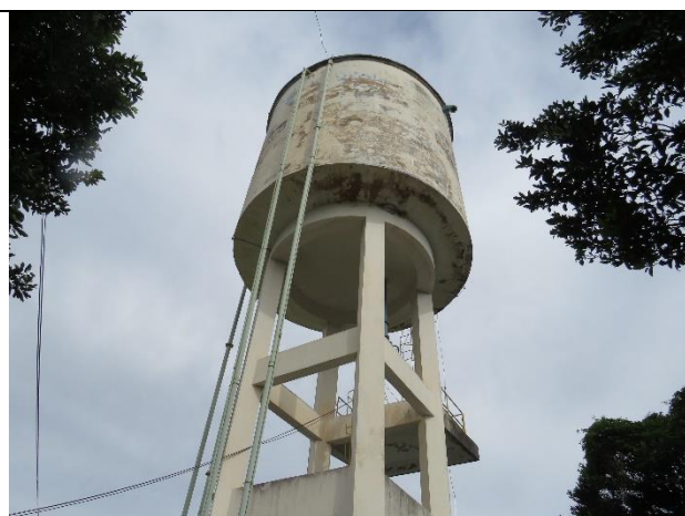
Autor: AMAE Descrição: Reservatório Elevado
