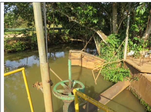
Autor: AMAE/RIO VERDE Descrição: Canal para captação de água.
