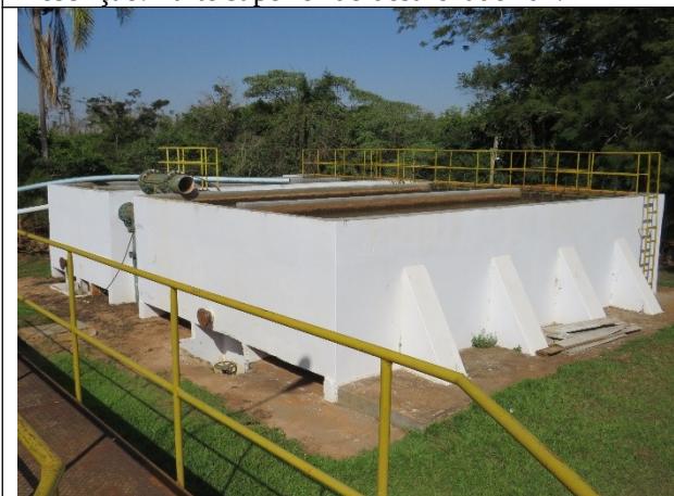
Autor: AMAE/RIO VERDE Descrição: Vista do desarenador 02, reformado.
