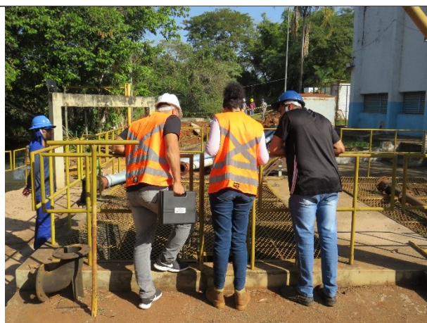
Autor: AMAE/RIO VERDE Descrição: Ponto de bombeamento de água para o desarenador.
