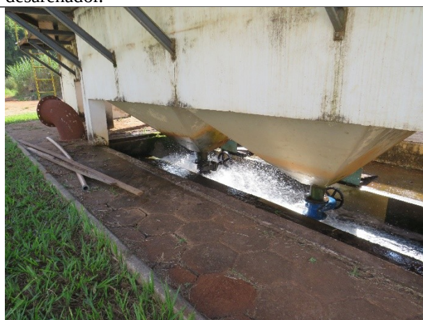
Autor: AMAE/RIO VERDE Descrição: Parte inferior do desarenador 01.
