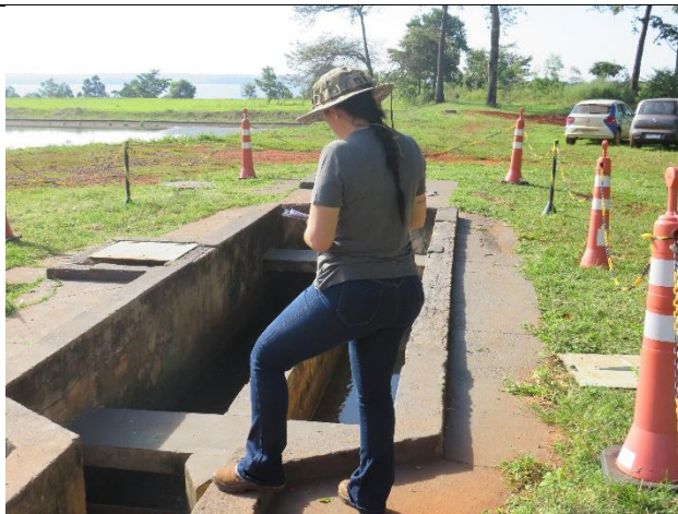
Autor: AMAE Descrição: Avaliação das caixas de areia.
