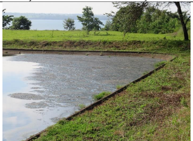
Autor: AMAE Descrição: Material sobrenadante na lagoa anaeróbica.
