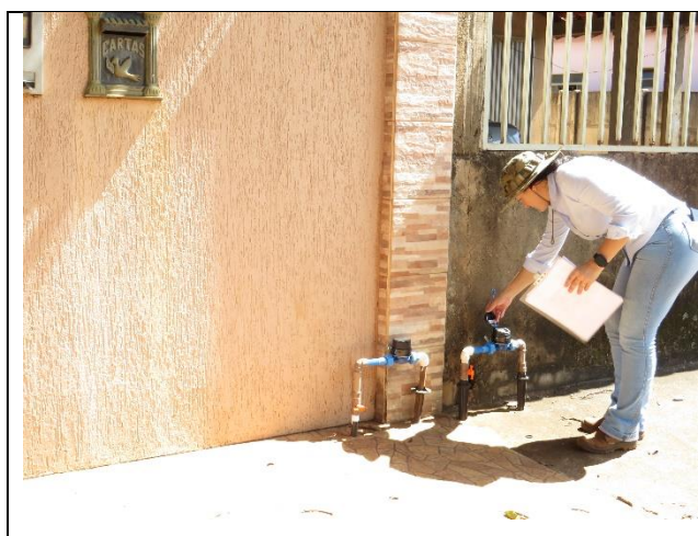
Autor: AMAE Descrição: Verificação da hidrometração.
