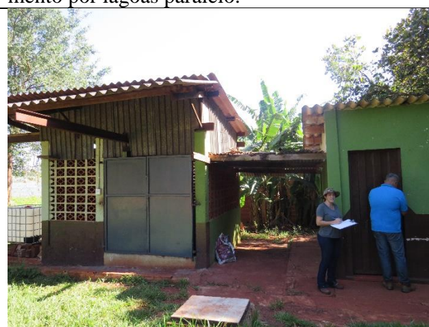
Autor: AMAE Descrição: Poço úmido à esquerda e poço de bombas.
