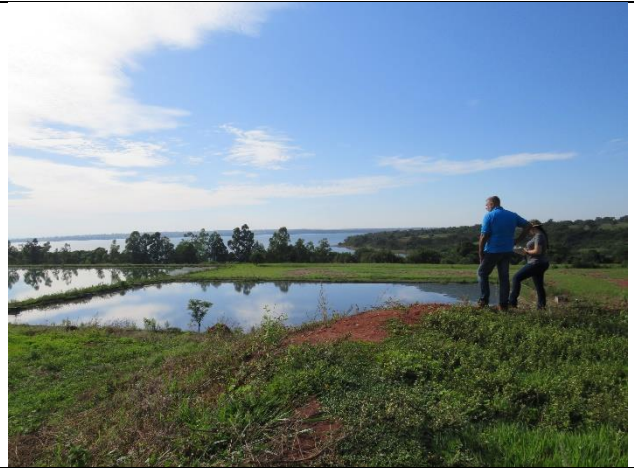
Autor: AMAE Descrição: Identificação do sistema de tratamento por lagoas paralelo.
