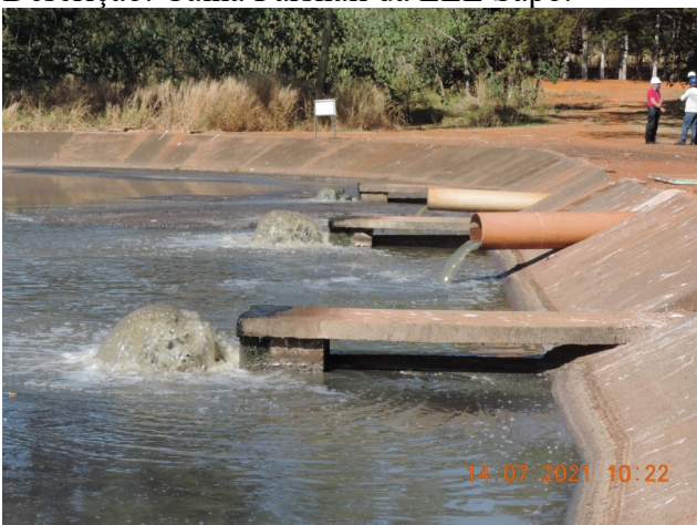
Autor: AMAE/RIO VERDE Descrição: local de lançamento de efluente nas lagoas de tratamento da ETE Sapo
