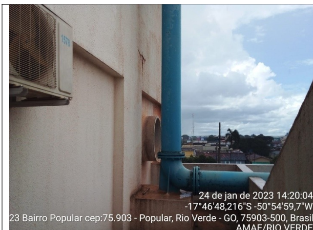
Autor: AMAE Descrição: REL Zona Alta II – tubo extravasor para processo de uso interno.
