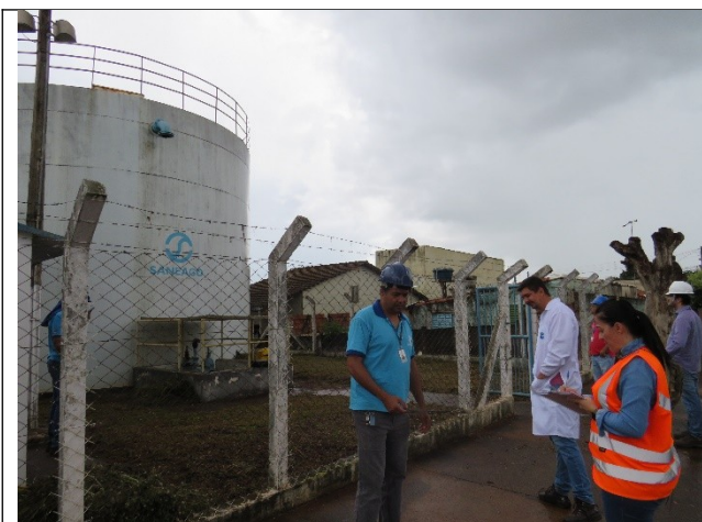
Autor: AMAE Descrição: RAP MARANATA – Sem placa de identificação.
