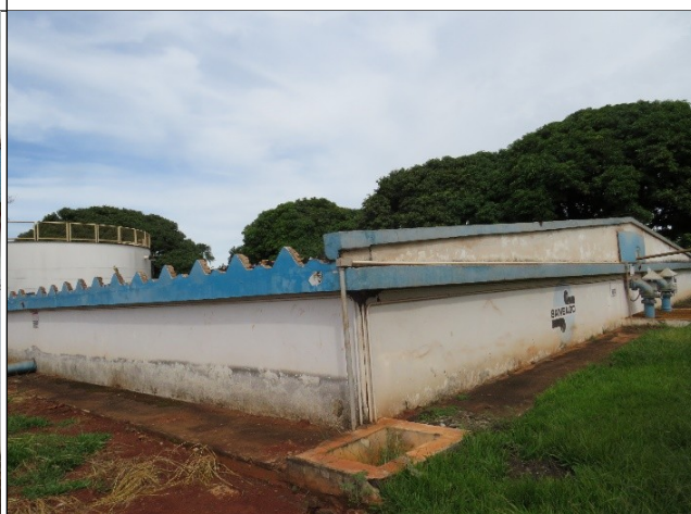
Autor: AMAE Descrição: RAP Quadrado desativado.
