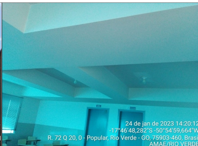
Autor: AMAE Descrição: REL Zona Alta II – Fundo do reservatório.
