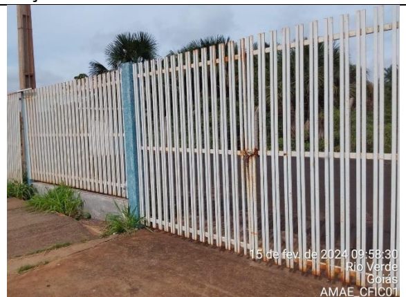
Autor: AMAE Foto: Ausência de placa de identificação no Poço PP1 – Portal dos Ipês.
