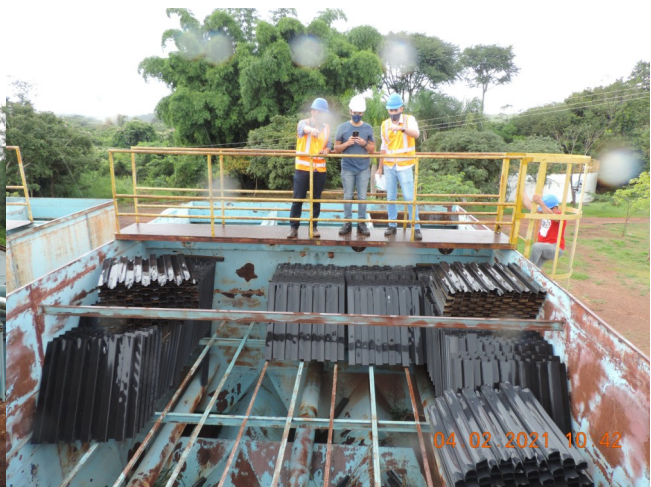
Autor: AMAE/Rio Verde Descrição: Verificação dos equipamentos já instalados
