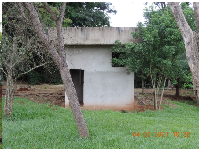
Autor: AMAE/Rio Verde Descrição: Construção em fase de acabamento.
