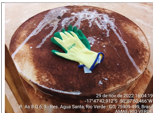
Autor: AMAE Descrição: Corrosão na tampa de inspeção do REL Água Santa.
