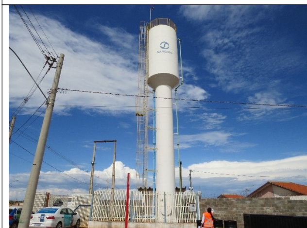
Autor: AMAE Descrição: Identificação do gotejamento na sonda telemétrica REL Goiânia
