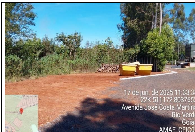
Autor: AMAE – figura 1. Foto: Área aos fundos da ETE Chapadinha sem isolamento através de alambrados.
