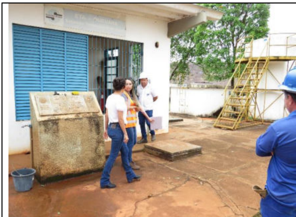
Autor: AMAE/RIO VERDE Descrição: Equipes da AMAE e da prestadora na ETA Ouroana.
