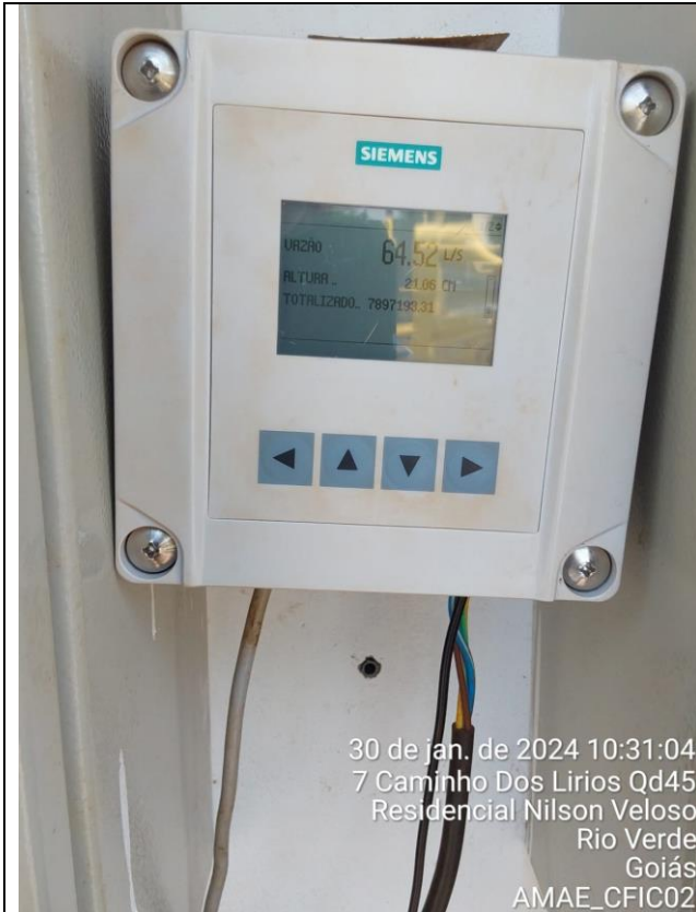
Fonte: AMAE Descrição: Vazão aferida pelo sensor ultrassônico.
