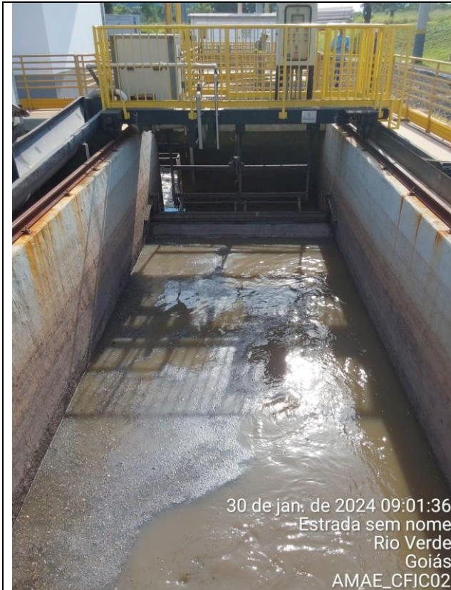
Fonte: AMAE Descrição: Desarenador.
