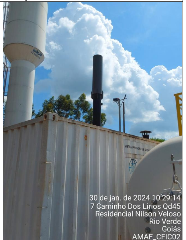
Fonte: AMAE Descrição: Saída dos gases do desodorizador.
