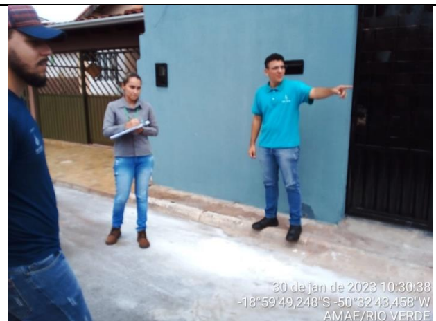
Autor: AMAE Descrição: Equipe da AMAE realizando a conferência de hidrômetros instalados.
