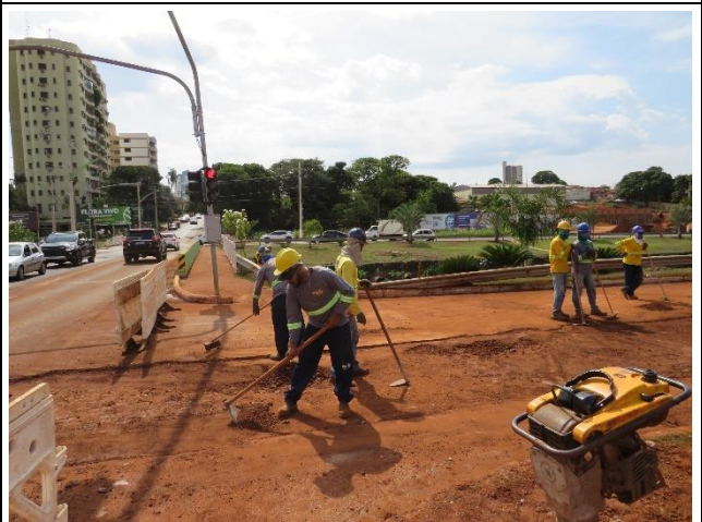
Autor: AMAE/RIO VERDE Descrição: Etapa final de interligação/ampliação da rede coletora SES Sapo – Av. Deputado Paulo Roberto Cunha em 11/05/2022.
