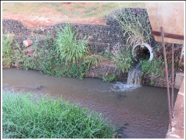
Autor: AMAE/RIO VERDE Descrição: escoamento de esgoto sanitário in natura no córrego Sapo, ocasionado pelo bloqueio do PV reparado (10/05/2022)
