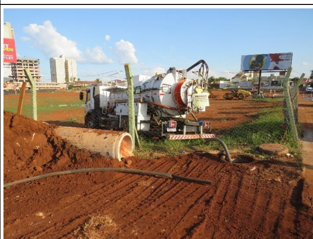
Autor: AMAE/RIO VERDE Descrição: Condições do local após intervenção da BRK Ambiental com destaque a sucção do esgoto para garantir o serviço realizado no PV (10/05/2022)
