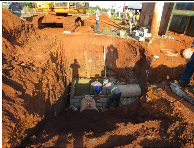
Autor: AMAE/RIO VERDE Descrição: Construção de PV para interligação/ampliação da rede coletora SES Sapo – Av. Deputado Paulo Roberto Cunha em 10/05/2022.
