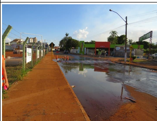
Autor: AMAE/RIO VERDE Descrição: extravasamento de esgoto sanitário na via ocasionado pelo bloqueio de PV para não interferir no PV reparado a jusante (10/05/2022)
