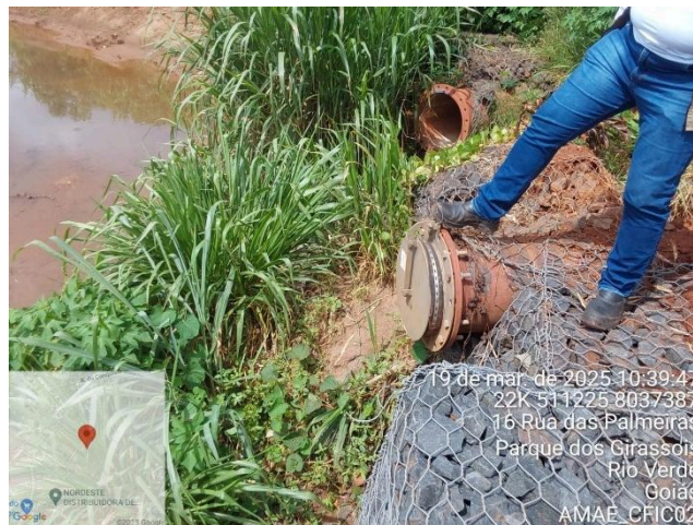
Autor: AMAE Tubo extravasor sem indícios de despejo recente (19/03/2025). Rio Verde/GO.
