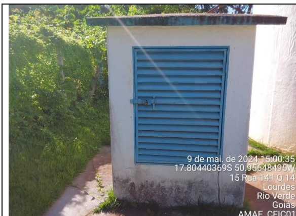
Autor: AMAE Foto: Caixa de comando do Booster Laranjeiras sem aviso de risco de choque elétrico.
