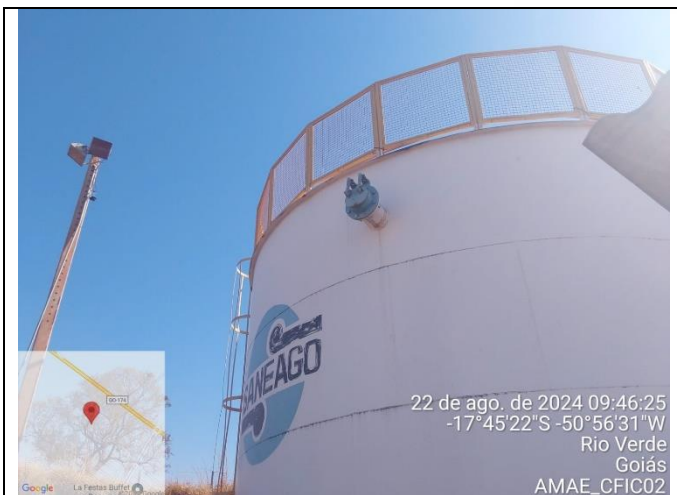
Fonte: AMAE Descrição: RAP Bela Vista – Extravasador com proteção.
