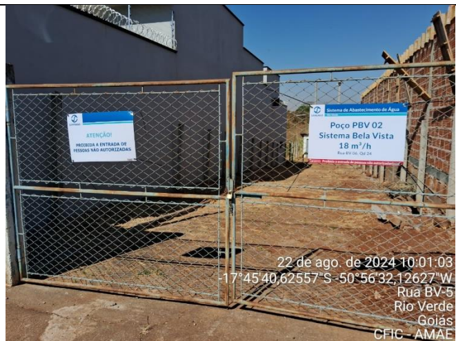
Fonte: AMAE Descrição: Poço PBV-02 Bela Vista
