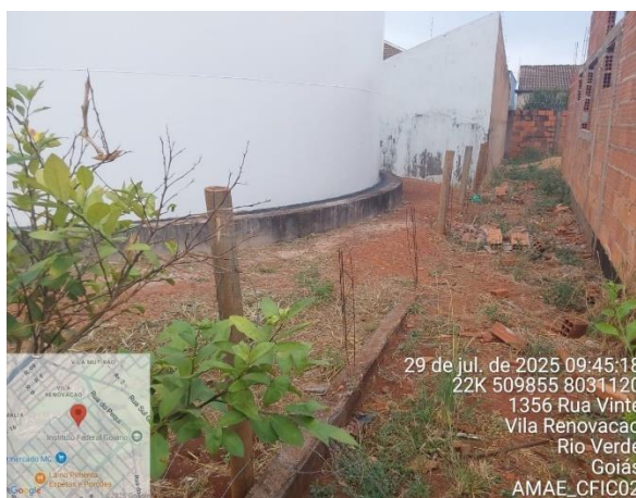
Figura 3: Isolamento inexistente do RAP Gameleira II.
