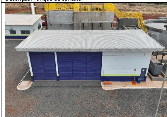
Figura. 11 – Elemento Fiscalizado: ETE Laje. Descrição: Centro operacional
