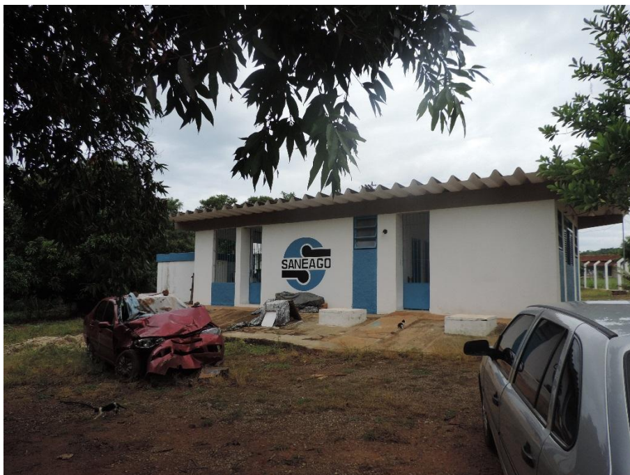
IMAGEM: Estação de Tratamento de Água – ETA.
