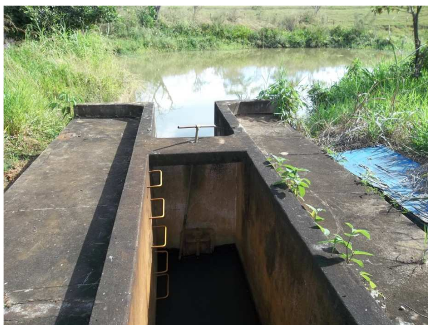
Figura 13 – Captação de água na represa formado pelo Córrego Dois Irmãos
