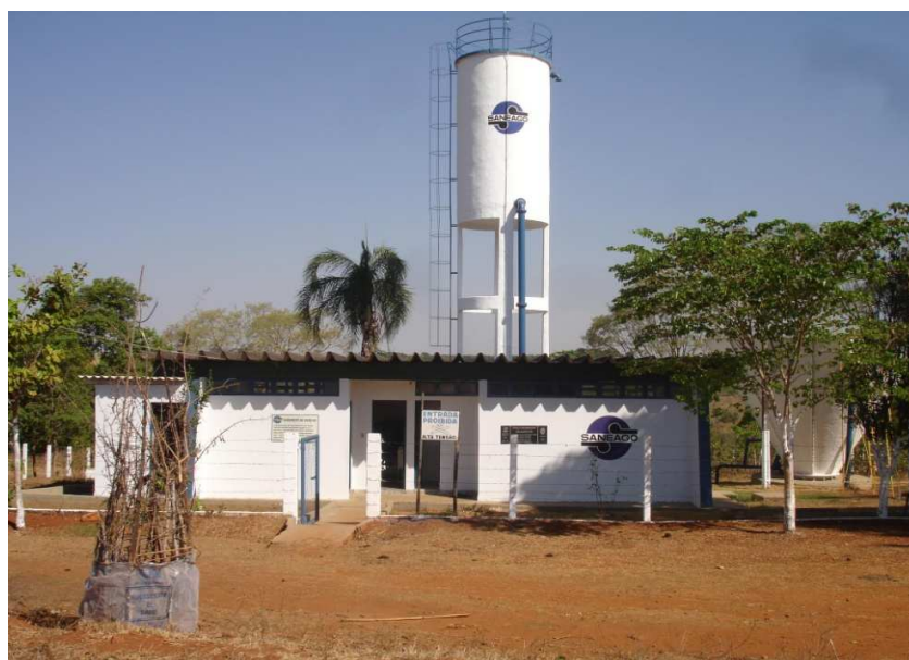
Figura 18: Reservatório 03 (Elevado) de Manutenção da ETA
