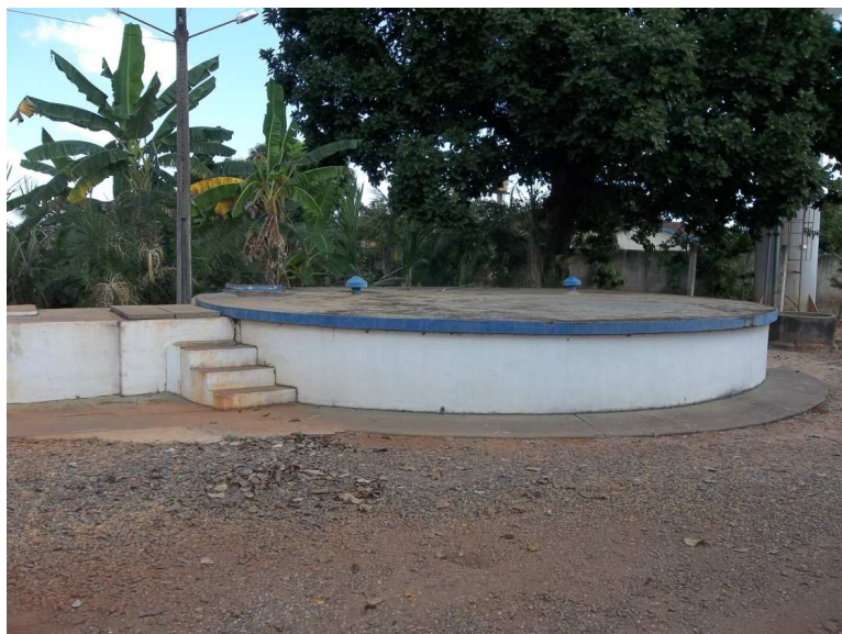
Figura 16: Reservatório 01 (Semienterrado) de Distribuição
