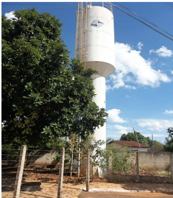
Figura 17: Reservatório 02 (Elevado) de Distribuição
