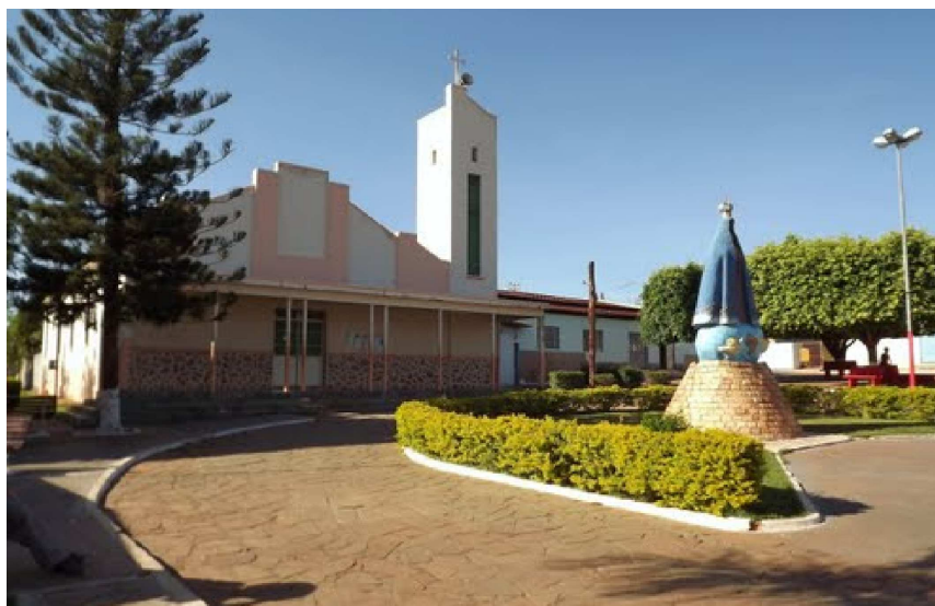
Figura 8 – Vista da Igreja de Avelinópolis
