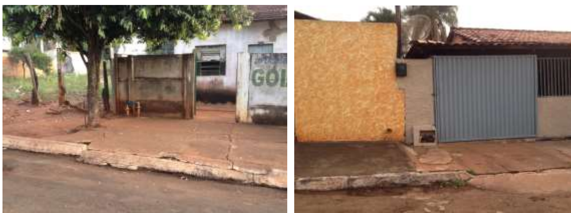
Figura 13 - Ligação padrão SANEAGO com hidrômetro
