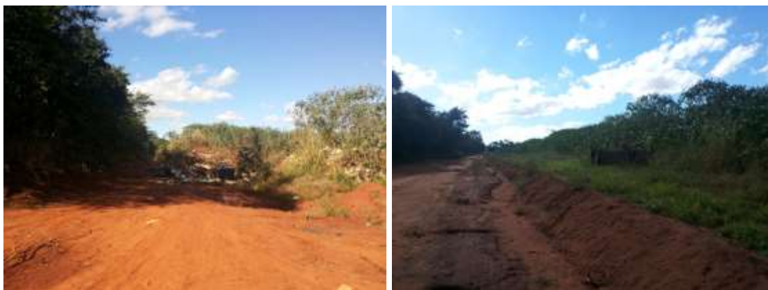
Figura 38 – Estrada de acesso ao Lixão de Cachoeira Alta
