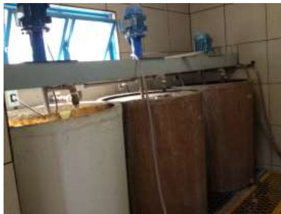
Preparo dos Produtos Químicos
