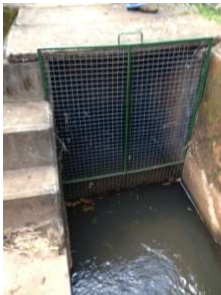
Canal de Entrada
