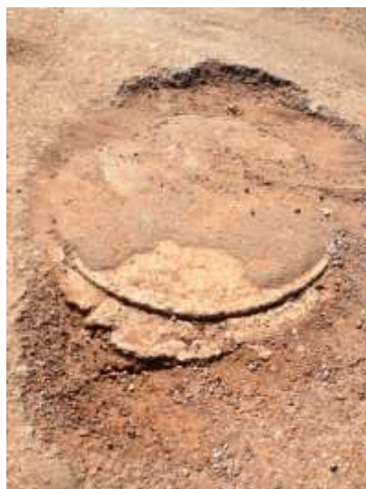
Figura 14 - Relatório fotográfico (Poços de visita)
