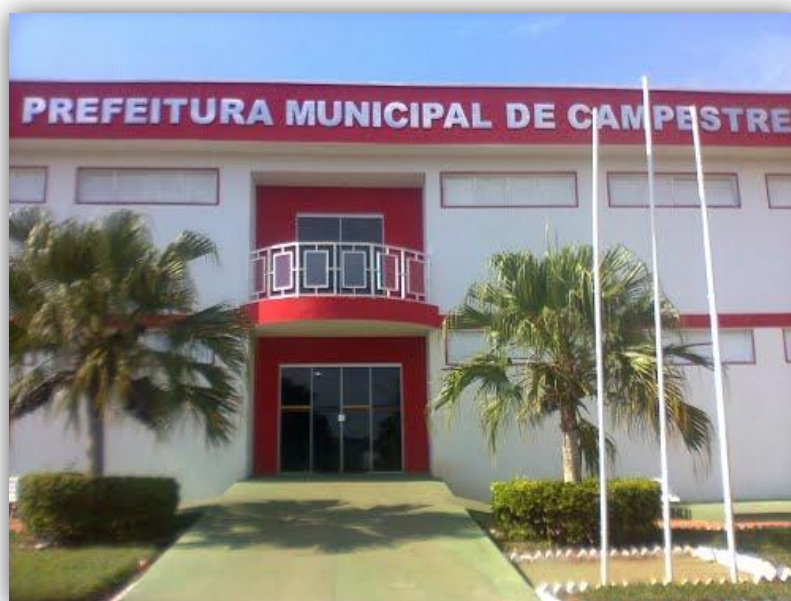
Figura 10– Prédio da Prefeitura Municipal Fonte: Google maps
