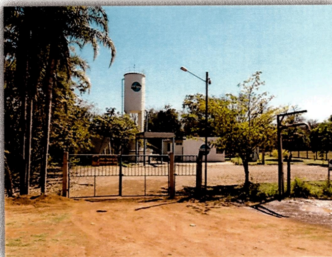
Figura 11: Vista da ETA e do Reservatório
