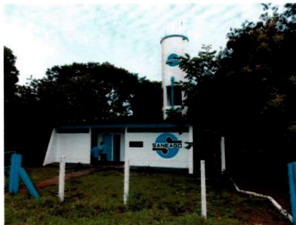
Figura 6 - Estação de Tratamento de Água – 2014. Fonte: Geoplano.
