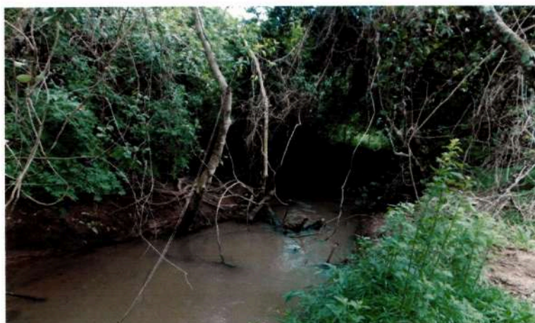
Figura 27 – Rio dos Bois em Processo de Assoreamento e Degradação
