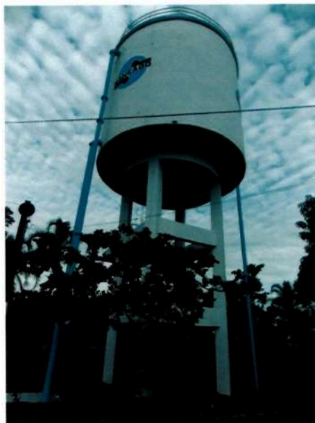
Figura 19 - Reservatório – 2014. Fonte: Geoplano
