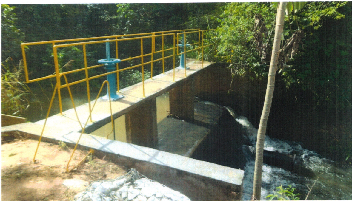
Figura 2.1.3.1-1. Captação de água para abastecimento, em Edealina.
