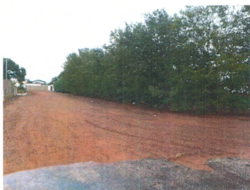
Figura 2.3-1. Transição de rua pavimentada para não pavimentada sem drenagem
