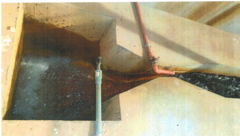
Figura 2.1.3.2-1. Dosagem de sulfato de alumínio na água bruta.
