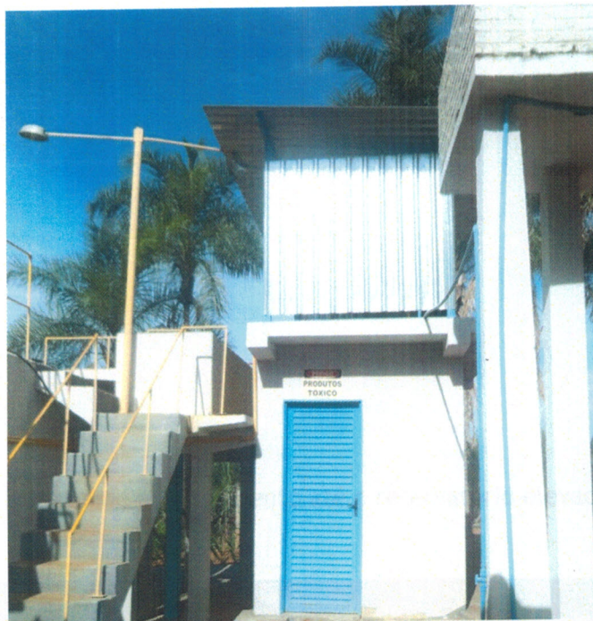
Figura 2.1.3.2-7. Área de armazenamento e produtos químicos.
