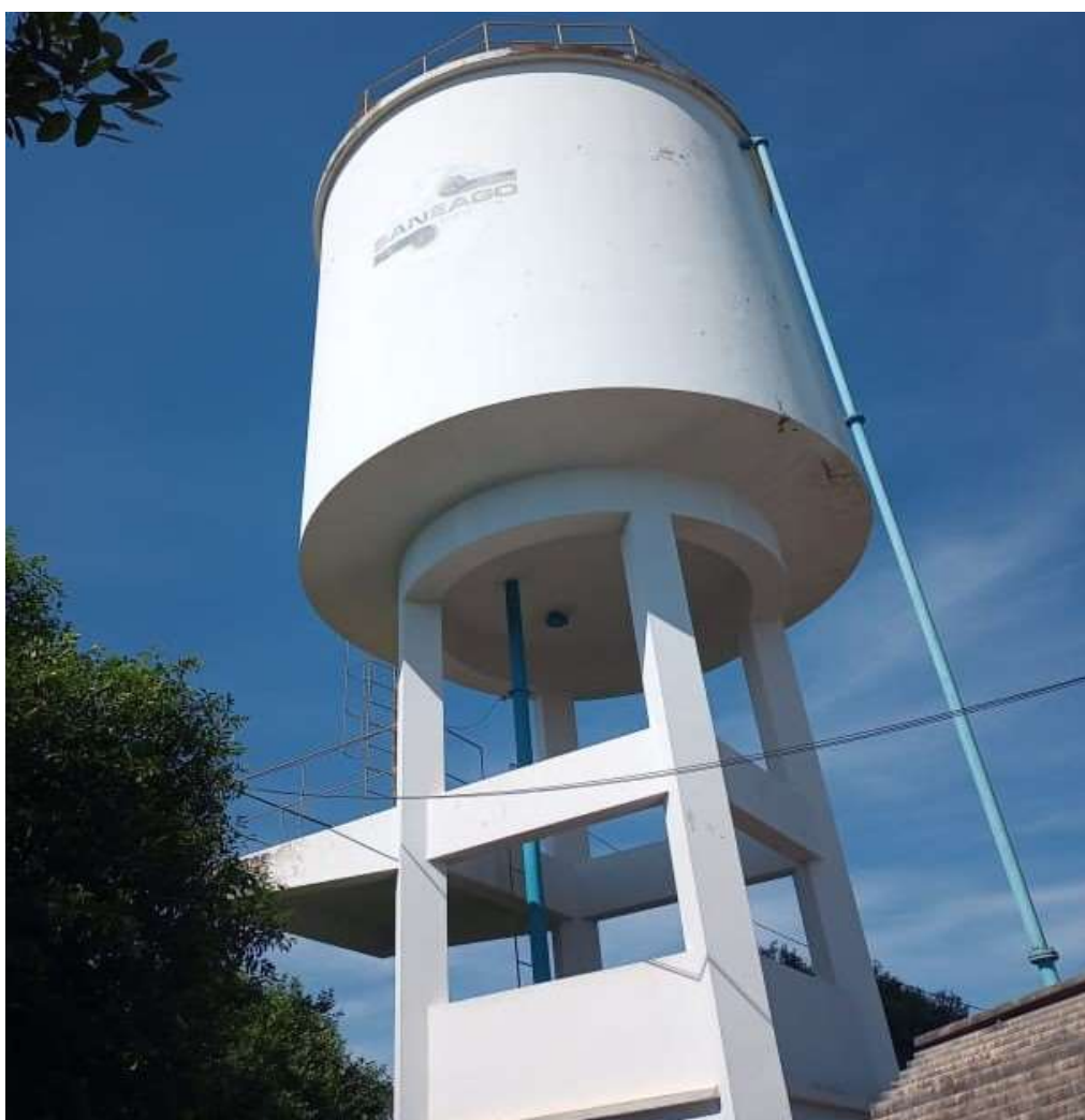
Figura 8 – Reservatório Elevado e Semi-enterrado
