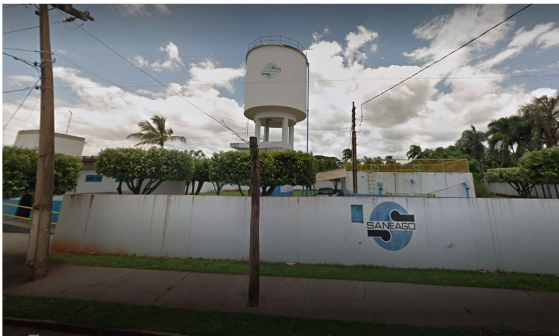
Figura 4: Escritório e Reservatório Elevado/ Fonte: SANEAGO
