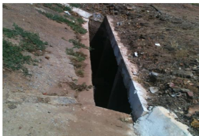
FIGURA 42 – BOCA DE LOBO DO MUNICÍPIO.
