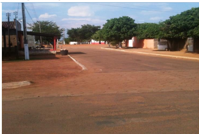
FIGURA 53 – RUA PAVIMENTADA POR ASFALTO.
