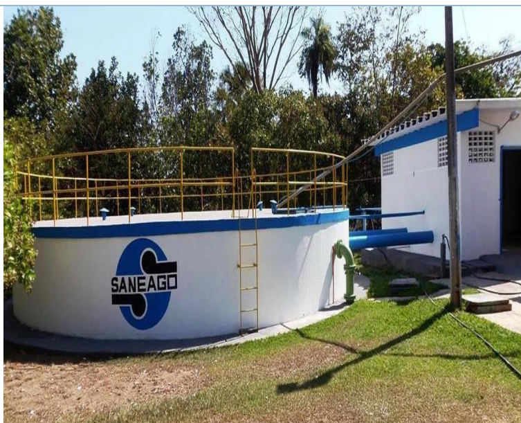
FIGURA 77 – RESERVATÓRIO SEMIENTERRADO (300 M³).
