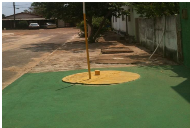
FIGURA 80 – FOSSA NEGRA RESIDENCIAL.
