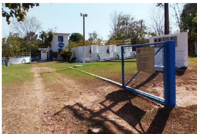
FIGURA 63 – ESTAÇÃO DE TRATAMENTO DE ÁGUA DE ITAPIRAPUÃ.
