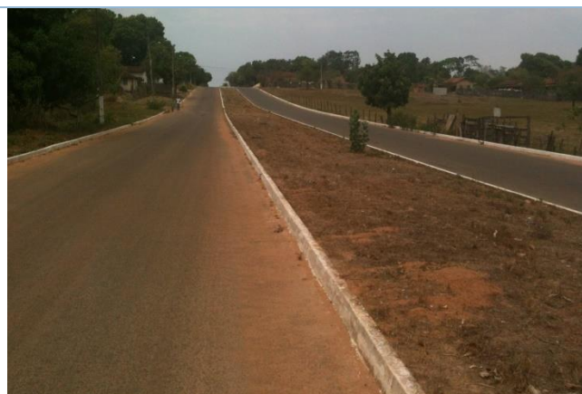
FIGURA 54 – RUA PAVIMENTADA POR ASFALTO.
