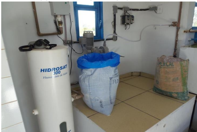
FIGURA 71 – BOMBA CLORADORA.
