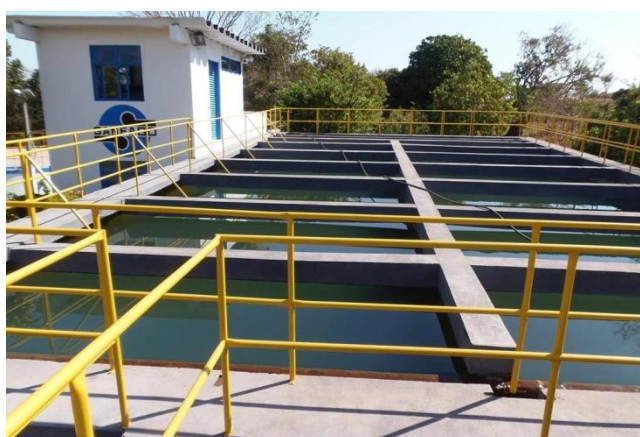
FIGURA 68 – TANQUES DE FLOCULAÇÃO.
