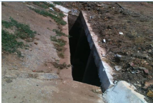
FIGURA 85 – ESTRUTURA DE MICRODRENAGEM.
