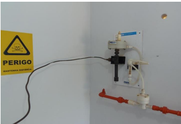
FIGURA 71 - BOMBA CLORADORA.
