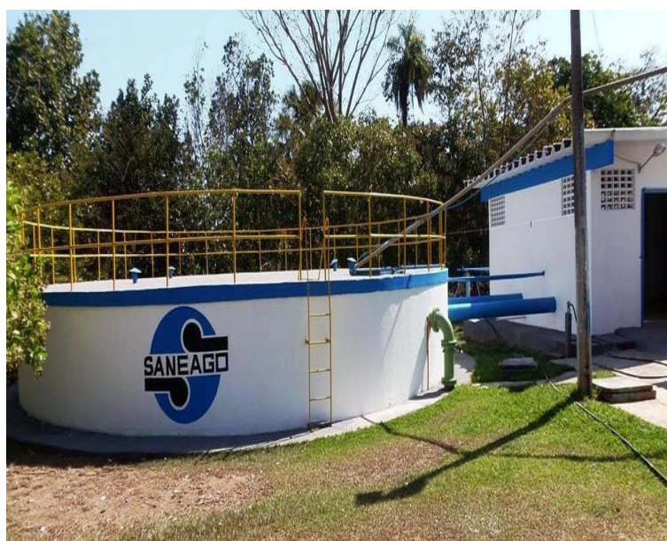
FIGURA 77 – RESERVATÓRIO SEMIENTERRADO (300 m³).
