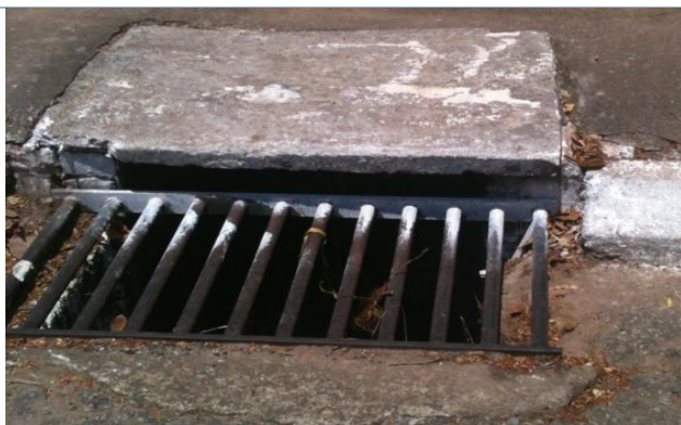
FIGURA 45 - BOCA DE LOBO DO MUNICÍPIO.
