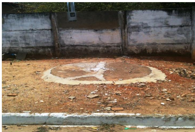
FIGURA 81 - FOSSA NEGRA RESIDENCIAL.
