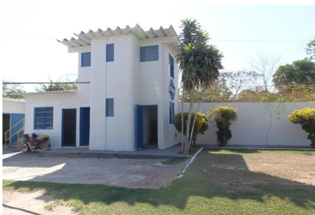
FIGURA 65 - ESTAÇÃO DE TRATAMENTO DE ÁGUA DE ITAPIRAPUÃ.
