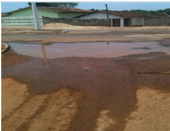
FIGURA 123 - ALAGAMENTO OCACIONADO PELA FALTA DE SISTEMA DE DRENAGEM PLUVIAL.
