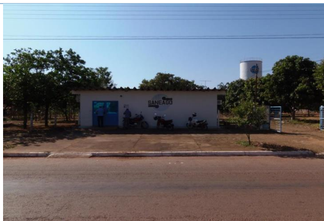
FIGURA 76 - ESTAÇÃO DE TRATAMENTO DE ÁGUA DE ITAPIRAPUÃ.
