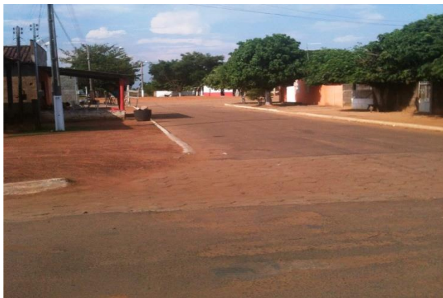
FIGURA 53 – RUA PAVIMENTADA POR ASFALTO.
