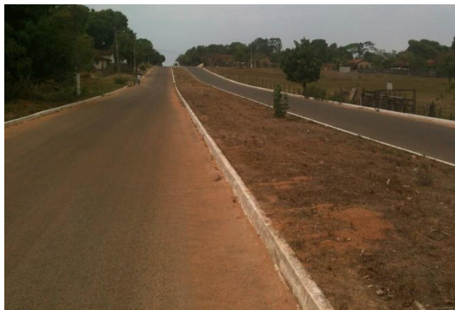
FIGURA 54 – RUA PAVIMENTADA POR ASFALTO.
