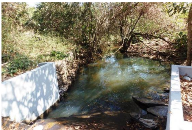
FIGURA 59 - CAPTAÇÃO DA ÁGUA BRUTA.
