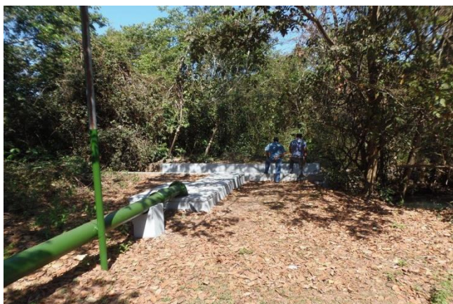
FIGURA 61 - CAPTAÇÃO DA ÁGUA BRUTA.
