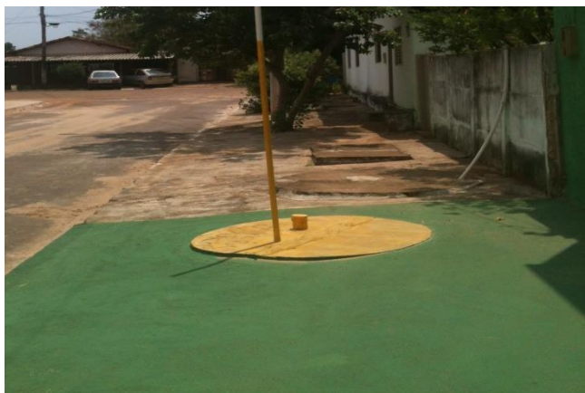
FIGURA 80 - FOSSA NEGRA RESIDENCIAL.
