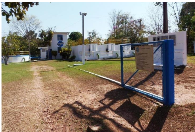
FIGURA 63 - ESTAÇÃO DE TRATAMENTO DE ÁGUA DE ITAPIRAPUÃ.
