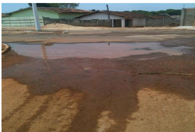
FIGURA 88 - EMPOÇAMENTO DAS RUAS DO MUNICÍPIO.
