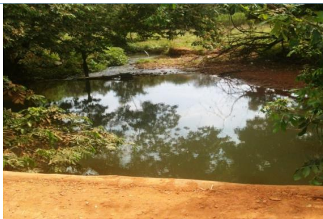
FIGURA 58 - MANANCIAL DE CAPTAÇÃO DE ÁGUA DO MUNICÍPIO DE ITAPIRAPUÃ.
