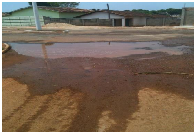
FIGURA 91 - EMPOÇAMENTO DAS RUAS DO MUNICÍPIO.
