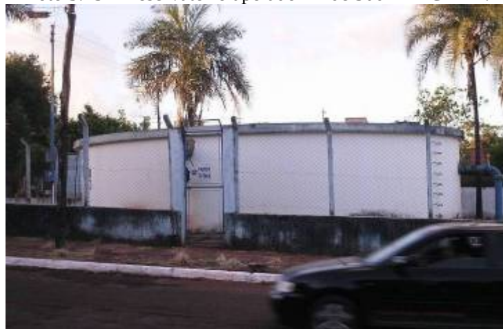
Foto 3.25 – Reservatório apoiado R4 de 500 m 3 - CR R4.
