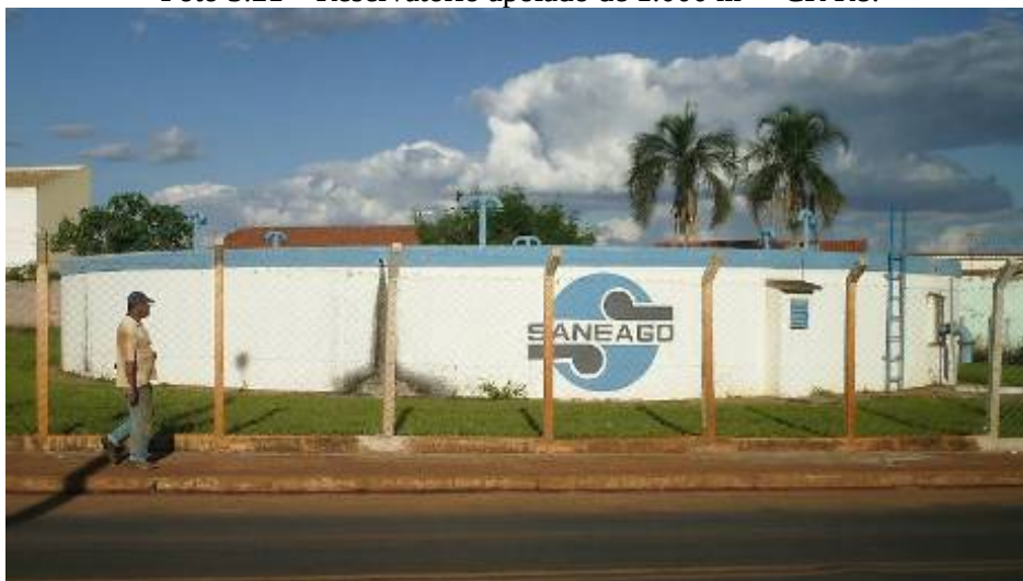
Foto 3.21 – Reservatório apoiado de 1.000 m 3 – CR R8.
