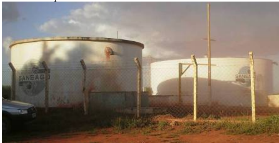
Foto 3.23 – Reservatórios apoiados R9 em concreto de 300 m 3 e R11 metálico de 500 m 3 - CR R9-R11.
