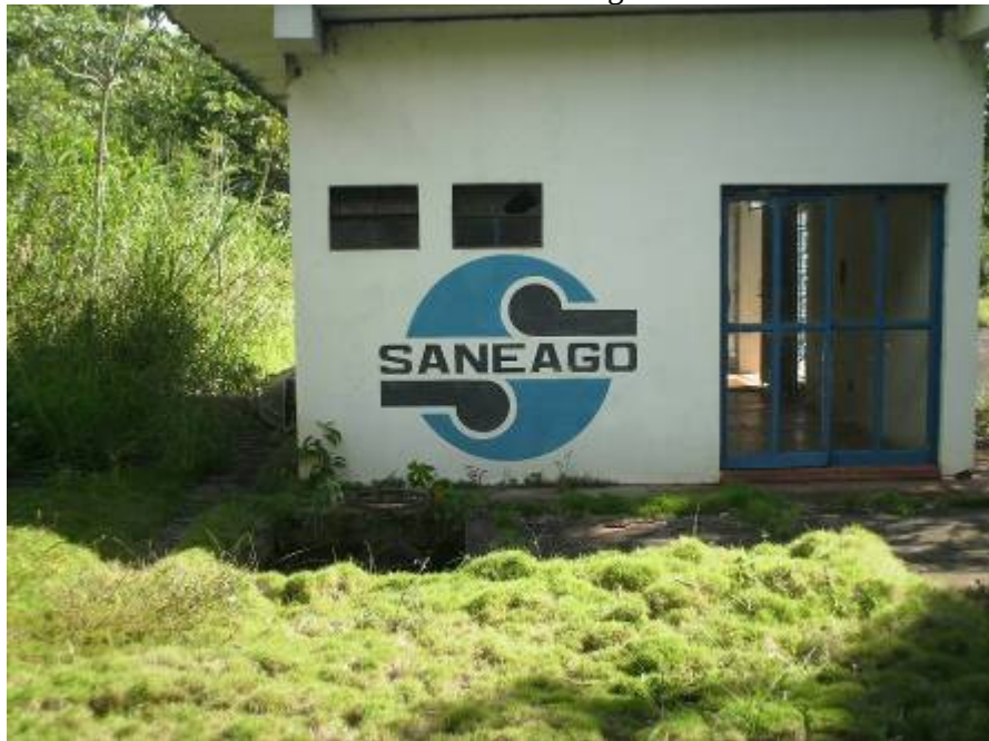
Foto 3.2 – Elevatória de Água Bruta.
