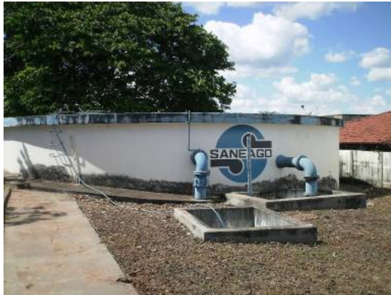
Foto 3.26 – Reserv. Semi-enterrado de 500 m 3 - CR R3.
