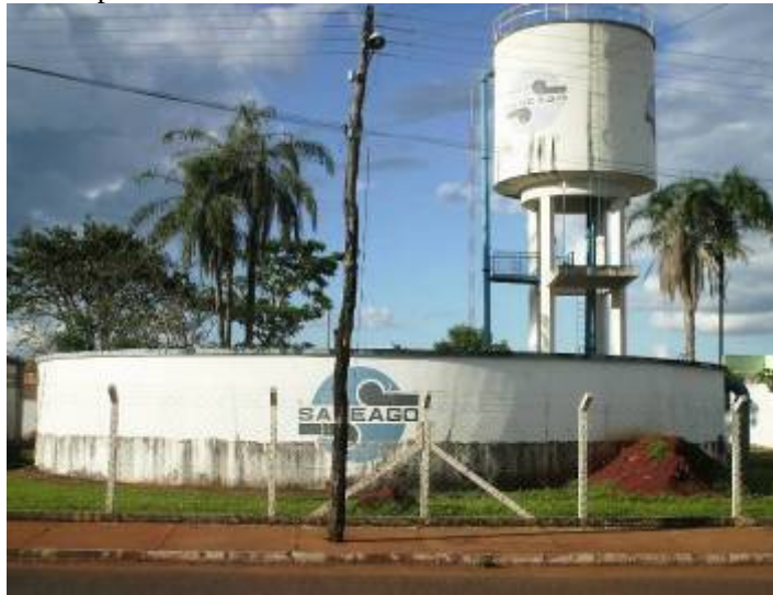
Foto 3.22 – Reservatório apoiado R7 de 3.000 m 3 e reservatório elevado R5 de 300 m 3 - CR R7-R5.
