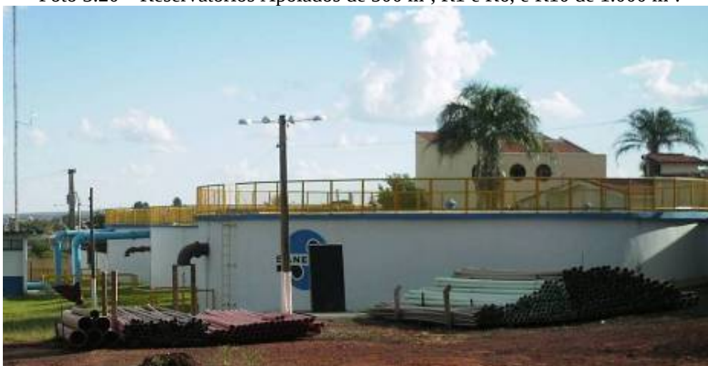
Foto 3.20 – Reservatórios Apoiados de 500 m 3 , R1 e R6, e R10 de 1.000 m 3 .
