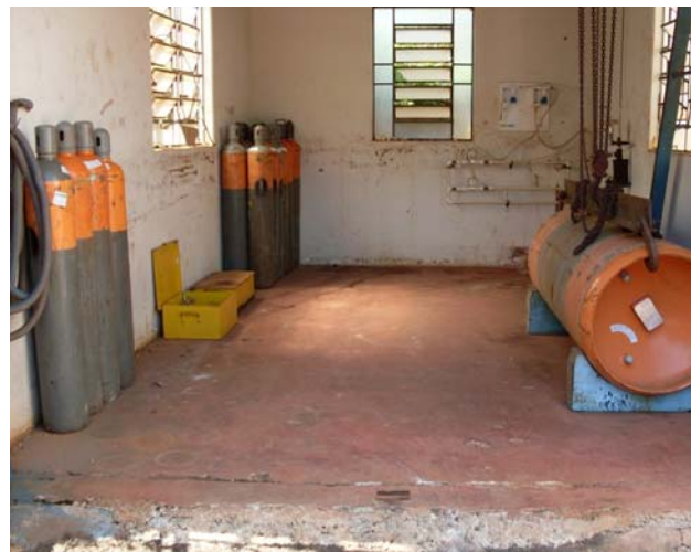
3.13 – Cilindros de cloro.
