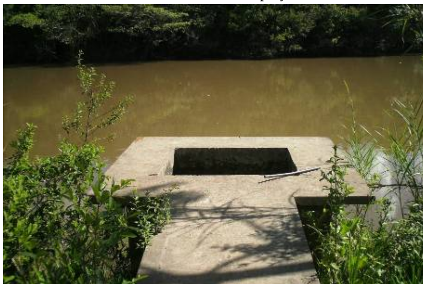
Foto 3.1 – Vista da captação.
