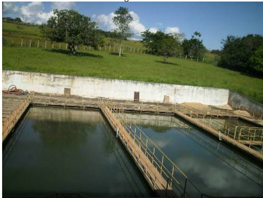
Foto 3.10 – Vista geral dos decantadores.
