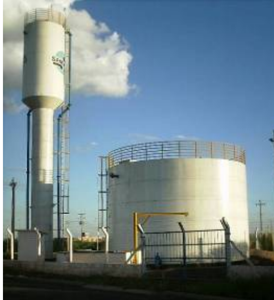
Foto 3.24 – Reservatório apoiado R13 de 400 m 3 e reservatório elevado R12 de 50 m 3 - CR R12-R13.
