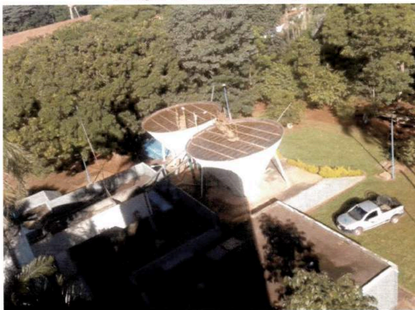
IMAGEM 23: Vista área da Estação de Tratamento de água.
