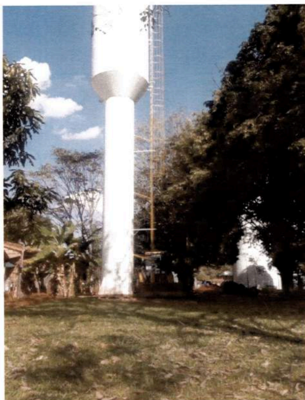
IMAGEM 24: Reservatório da ETA.
