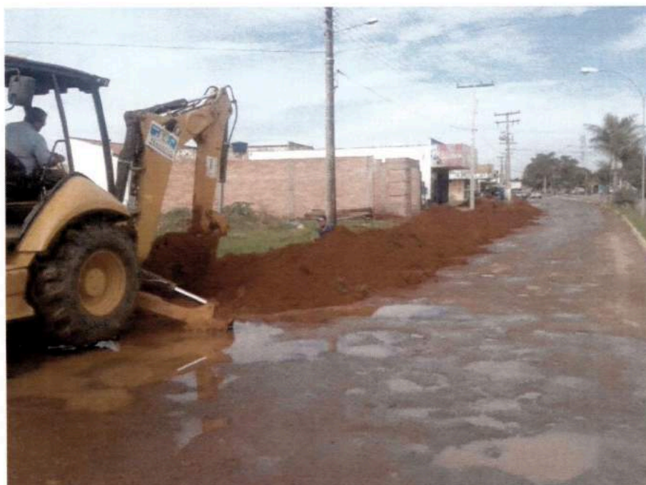
IMAGEM 26: Obras de infraestrutura realizada pela Saneago.
