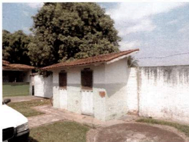
IMAGEM 41: Armazenamento Externo dos RSS ao lado da fossa.
