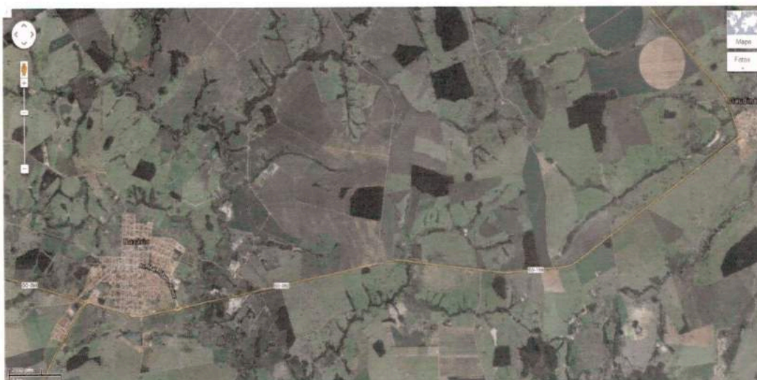
IMAGEM 19: Ponto de Captação e ETA de Nazário.
