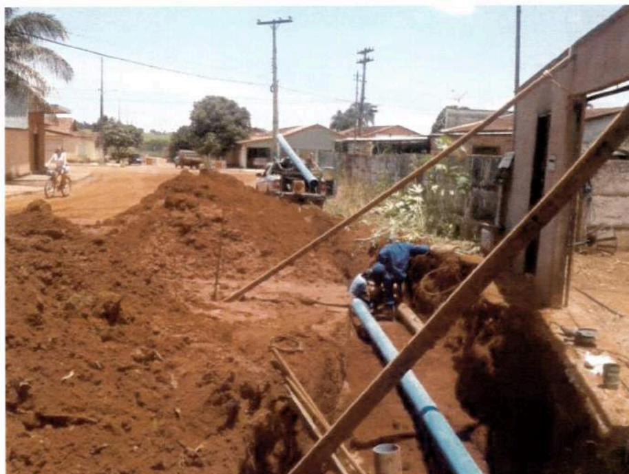
IMAGEM 25: Obras de infraestrutura realizada pela Saneago.
