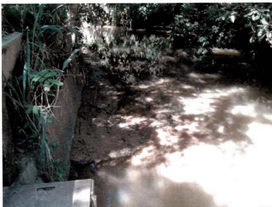
IMAGEM 22: Captação de água bruta.
