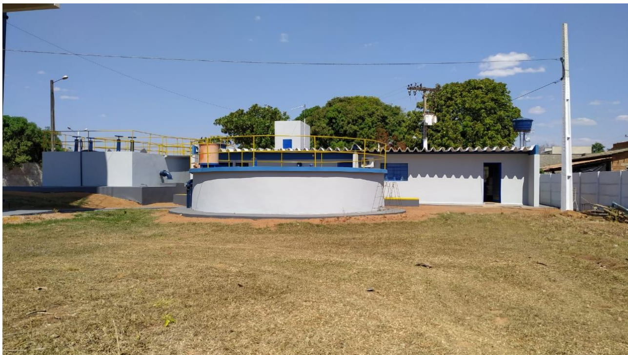
RSE (Reservatório semienterrado) com capacidade 150m³. (Fonte: Arquivo Pessoal)
