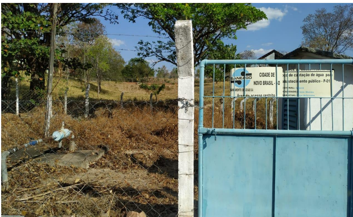
Poço e quadro de comando de Novo Goiás. (Fonte: Arquivo Pessoal)
