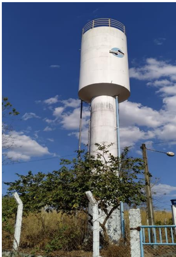
Reservatório de Novo Goiás – capacidade de 50m³. (Fonte: Arquivo Pessoal)
