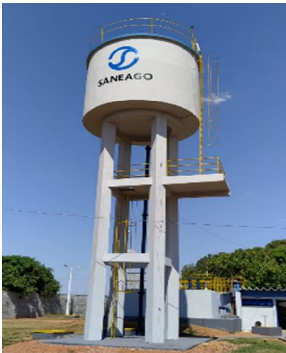
REL (Reservatório Elevado) com capacidade de 50m³. (Fonte: Arquivo Pessoal)
