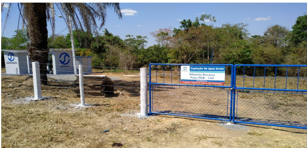
Captação de água de Novo Brasil. (Fonte: Arquivo Pessoal)
