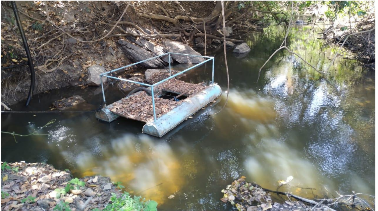
Balsa de captação do Ribeirão Bocaina. (Fonte: Arquivo Pessoal)
