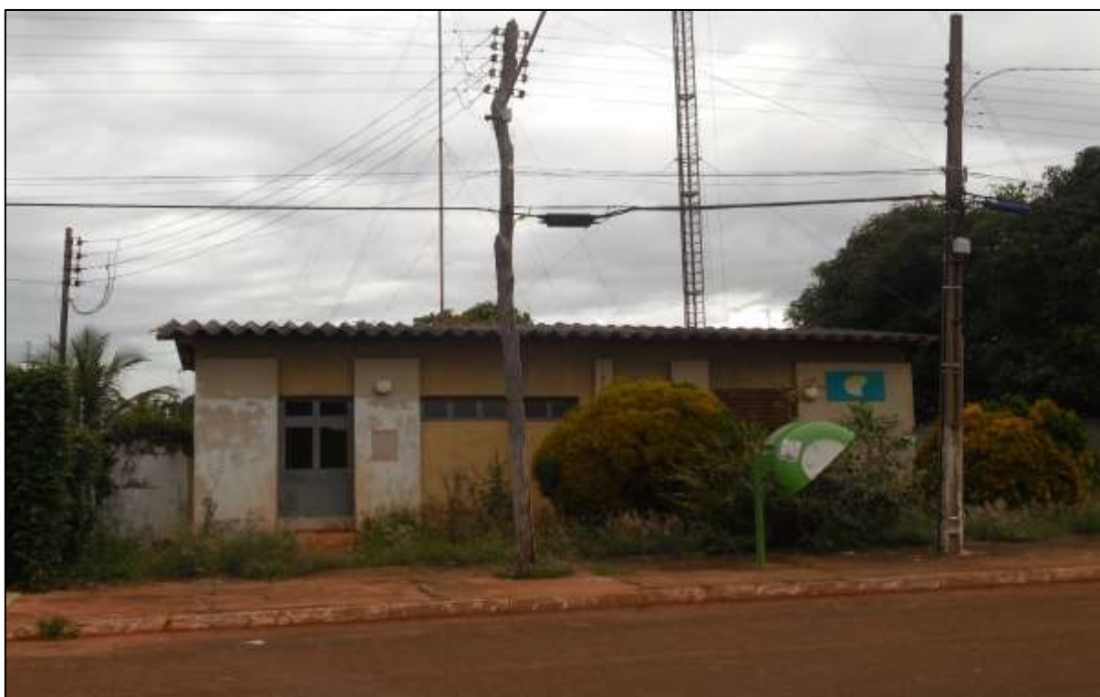
Figura 5. Torre de telefonia da operadora Oi.
