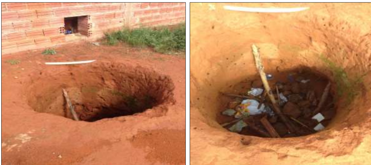
Figura 11. Fossa rudimentar encontrada no Assentamento Três Pontes.
