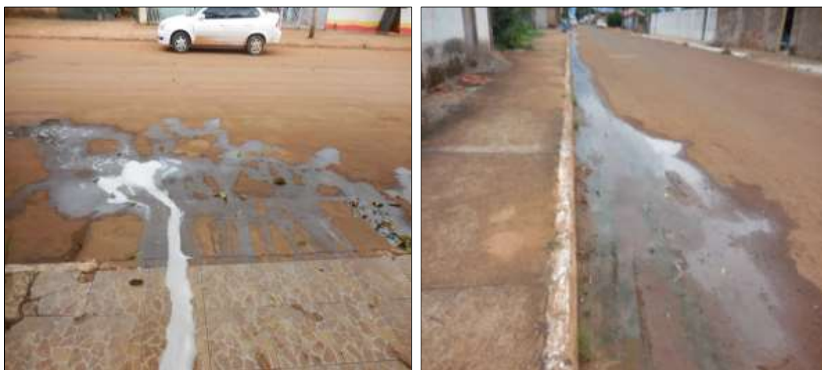
Figura 14. Lançamentos de águas servidas nas vias urbanas.
