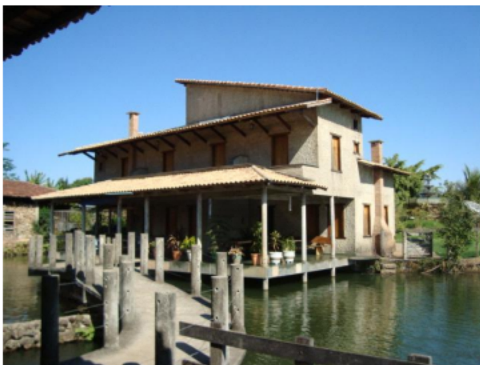
Figura 21 D - Sede da propriedade encontra-se dentro da represa – Area da represa destinada à dessedentação de animais.
