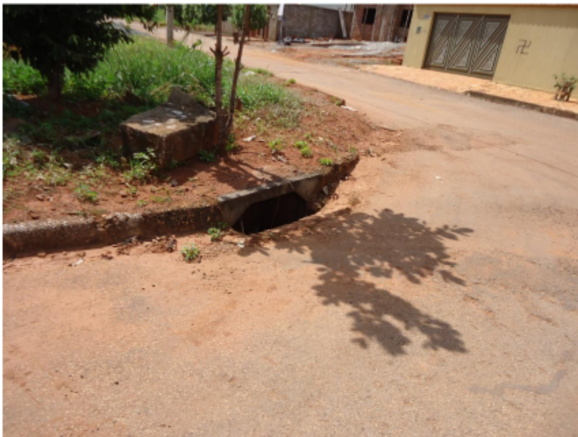
Figura 42 - Galeria Pluvial Na Rua Gilson Pereira Machado.
