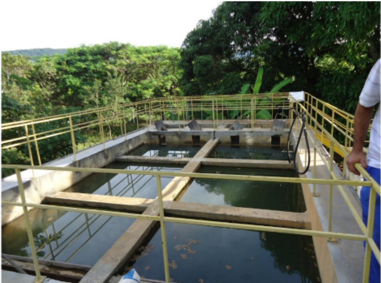
Figura 26 - Estação de Tratamento de Água
