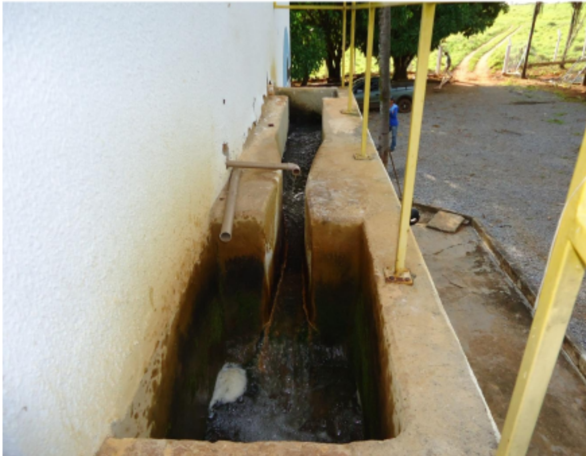
Figura 27 – Calha Parshall.
