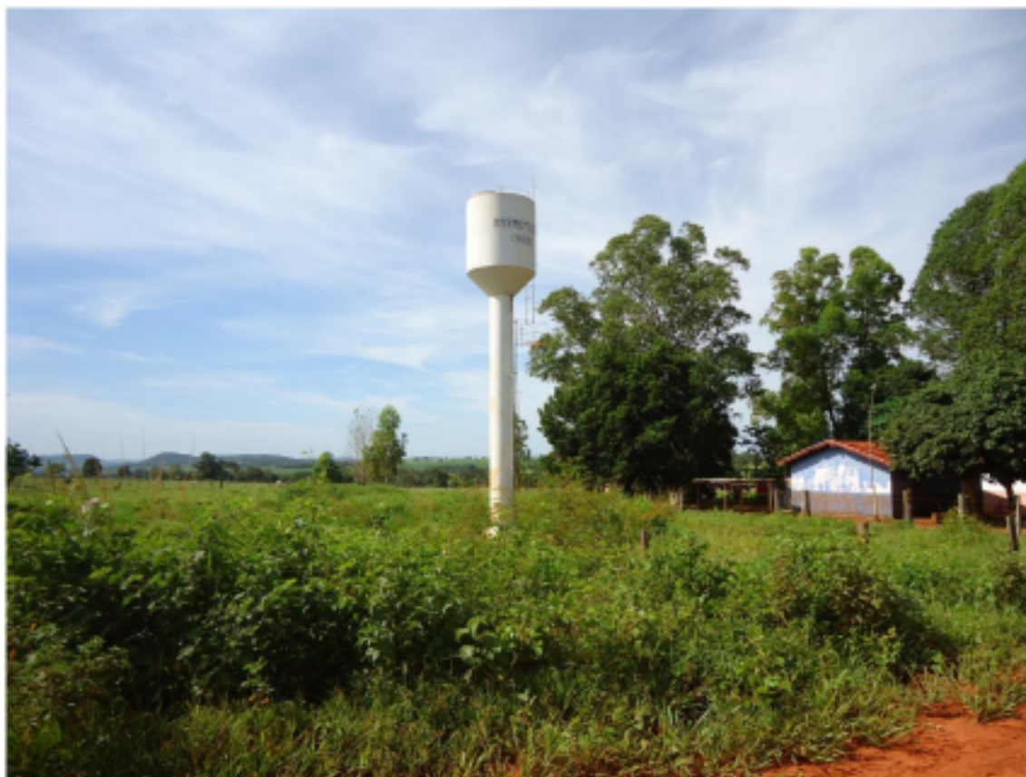
Figura 38 - Reservatório de Gercinópolis
