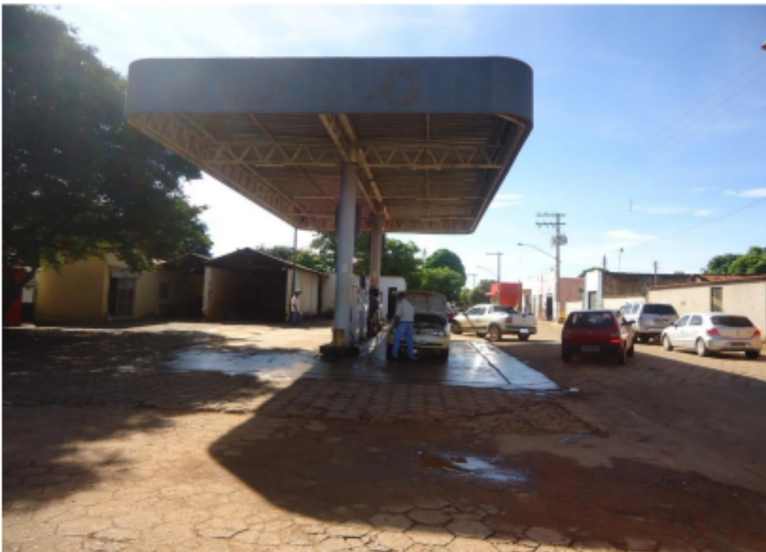
Figura 19 – Posto de Gasolina
