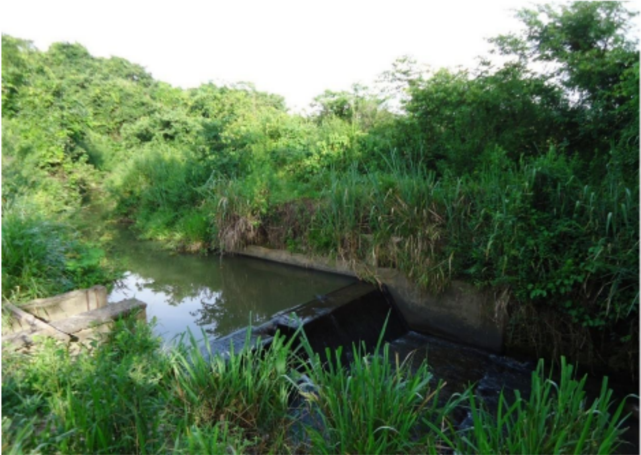
Figura 25 – Barramento No Ponto De Captação
