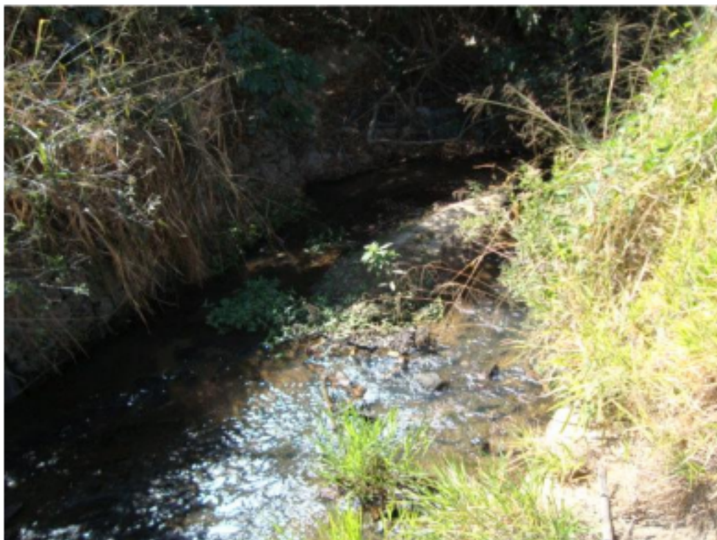
Figura 21 A - Captação de água da SANEAGO – Assoreamento (médio).
