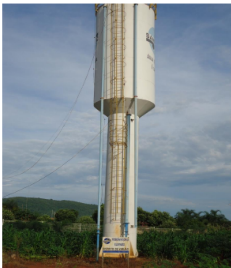
Figura35 - Reservatório Elevado Setor São Leopoldo.
