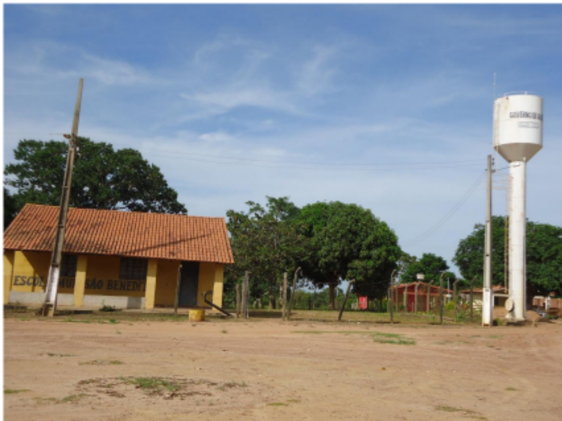
Figura 37 - Reservatório Povoado São Benedito
