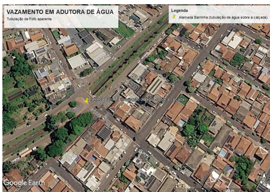
Figura 1: Identificação do local do vazamento no município de Rio Verde GO.
