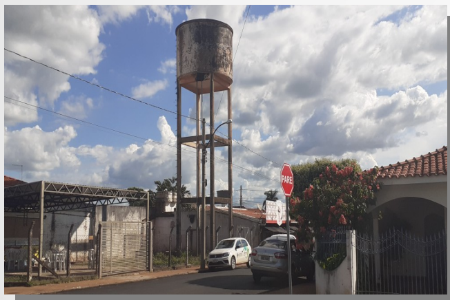
Figura 4 – Reservatório elevado Carolina
