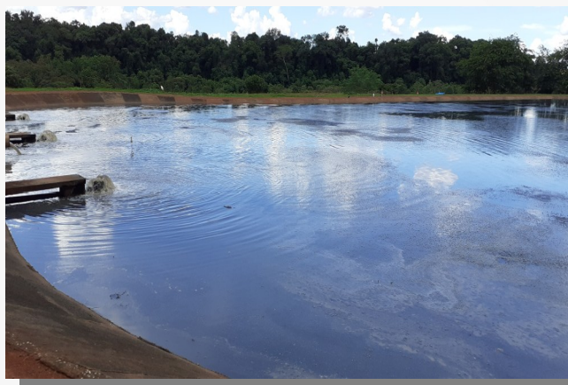
Figura 14 – Vistoria ETE Sapo
